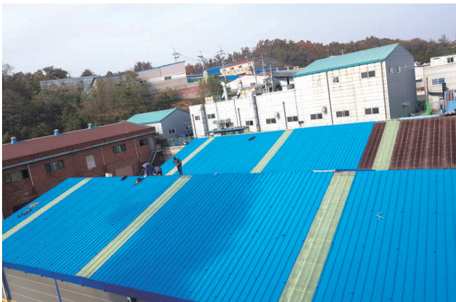
■ 노후 지붕-덧방 시공
